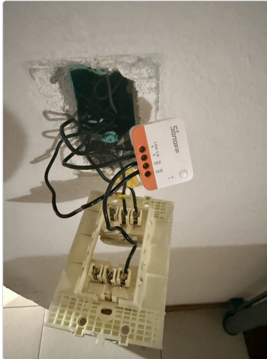
El Sonoff ZBMINI-L2 conectado en la caja: terminales L In / L Out (línea) y S1 / S2 (entradas de switch). El módulo va detrás de la tecla y conmuta la carga por Zigbee además del switch físico.
